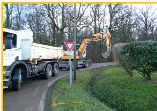
**Réparation route de Chaussin :** en juillet 2017, un tronçon de la route de Chaussin s'est effondré occasionnant des travaux importants. L'entreprise Bornier est intervenue très rapidement. Il a fallu ouvrir la route sur toute sa largeur, creuser sur une hauteur de 2 m, buser pour faciliter l'évacuation des eaux et reboucher. Coût de l'intervention : 2 378,40 € TTC.
